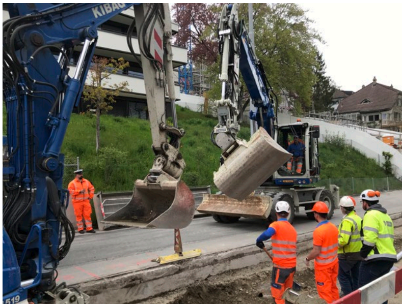
Auf der Baustelle «Höngger- und Limmattalstrasse» läuft alles nach Plan. (Foto: dad)
